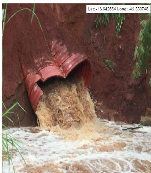
FIGURA 02 – Ilustração do bueiro rompido.
